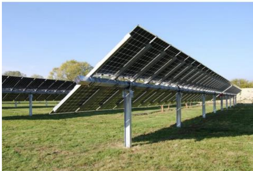
Figur 3-12. Foto af række med Tracker opstilling. Kilde: Ecosolar.
