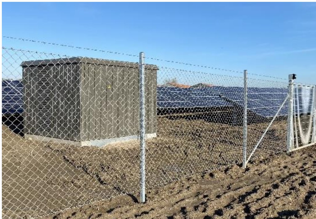
Figur 3-14 viser eksempler på, hvordan parktransformere kan se ud.
